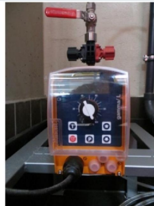
B) Dosing pump
