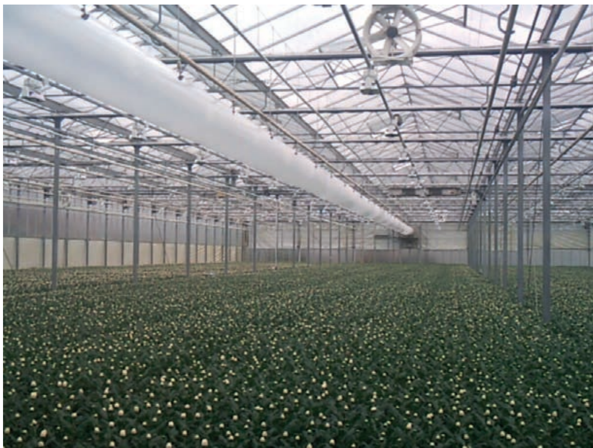
Figuur 3 Proefvak met luchtbehandelingsinstallatie.
