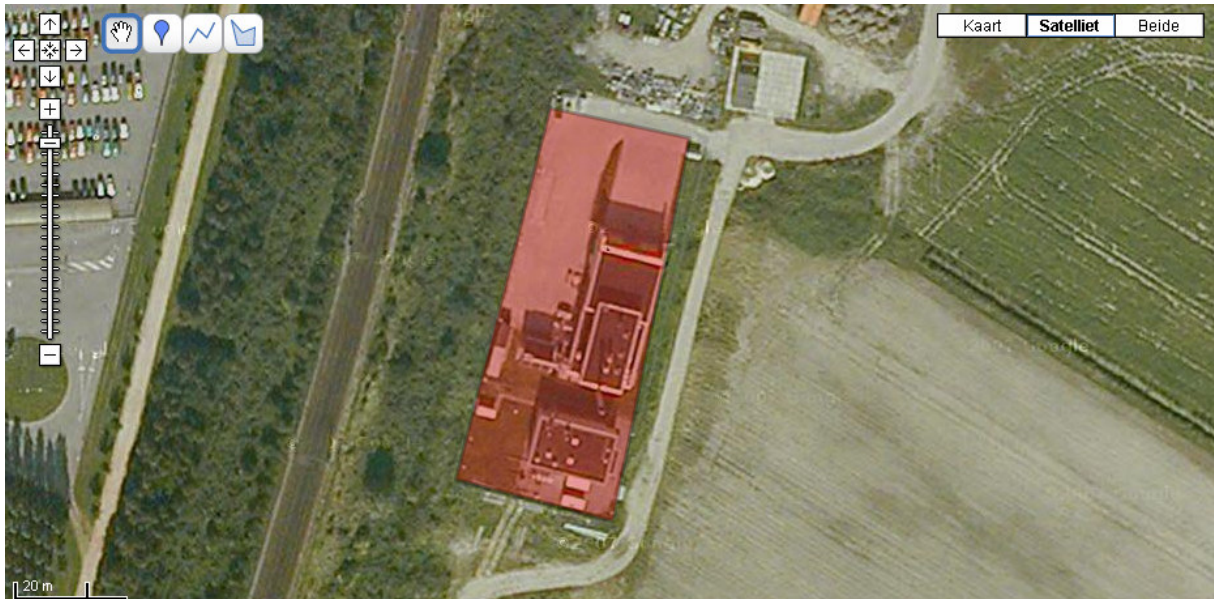
Figuur 5: luchtfoto 1,7 MWe houtverbrandingsinstallatie (in rood) (Lelystad)
