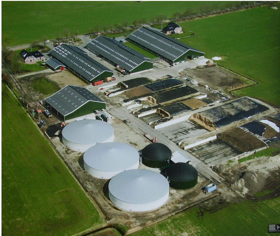
Figuur 3: luchtfoto 1 MWe co-vergistinginstallatie
