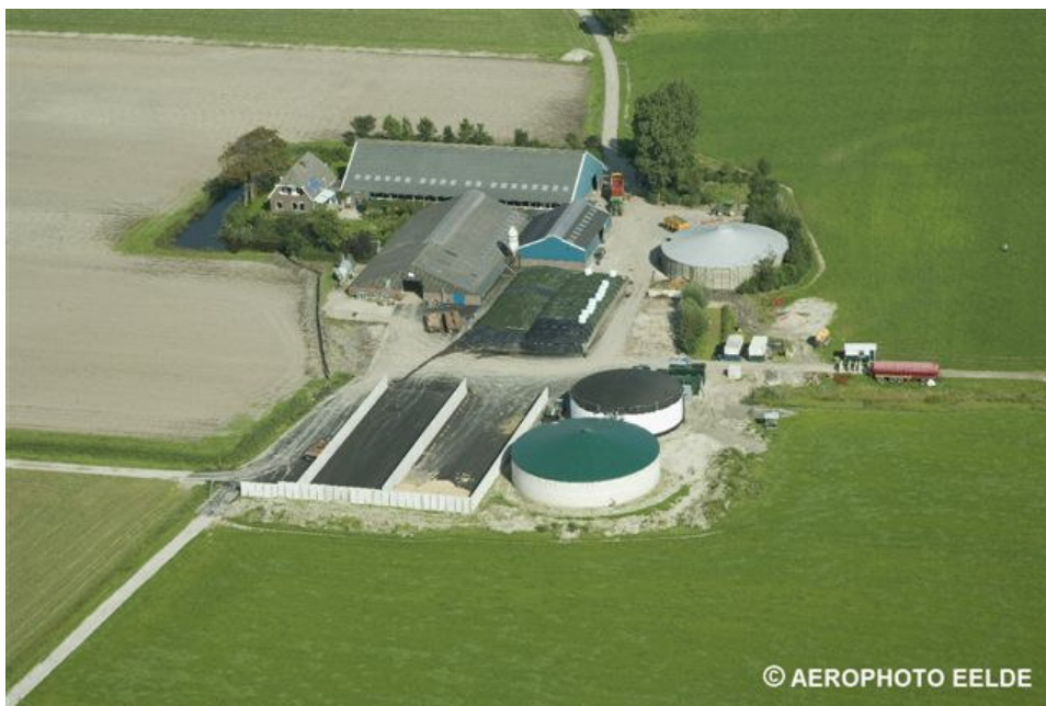
Figuur 2: luchtfoto 500 kWe co-vergistinginstallatie
