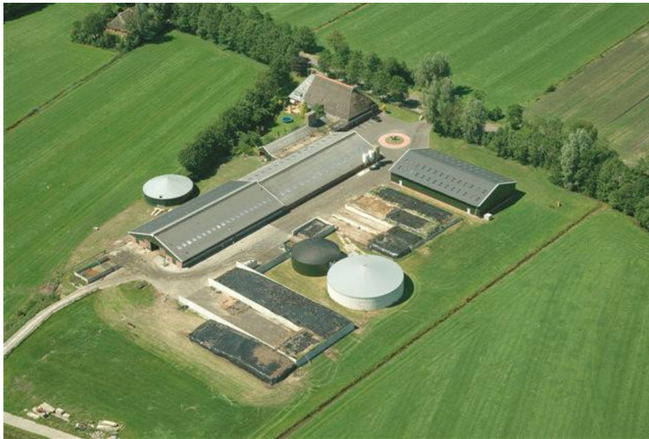
Figuur 1: luchtfoto 200 kWe co-vergistinginstallatie
