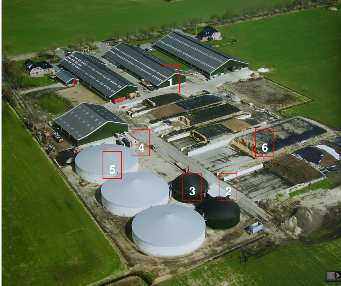
Figuur 3: luchtfoto 1 MWe co-vergistinginstallatie met aanduiding componenten (ref: Host)
