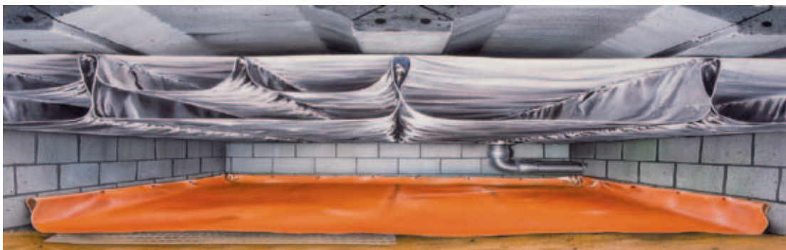
Figuur 5. Dubbele lagen gealuminiseerde folie met spouw.
