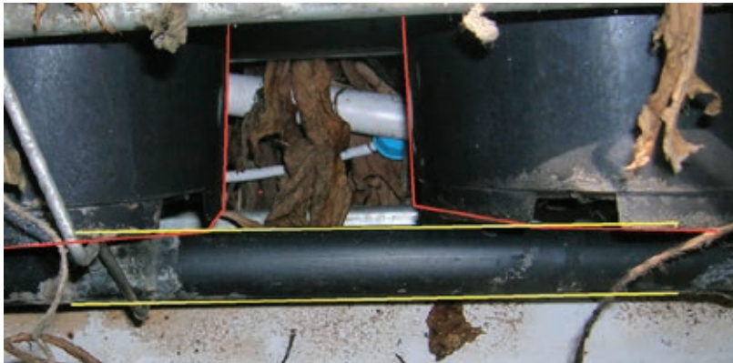
Figuur 1. De potverwarmingsslang die tegen de onderkant van de potten is gehangen. (Slang tussen gele lijnen, potten met rode lijnen aangeduid.)
