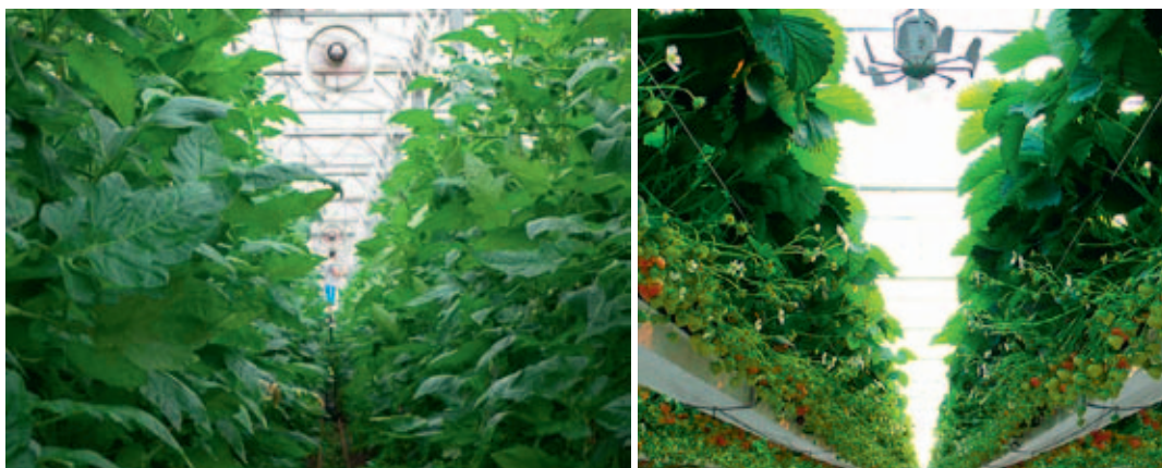
Figuur 7. Horizontale (Foto Groenten & Fruit, Boonekamp) en verticale ventilator (Foto Nivola).
