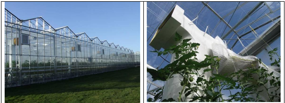
Figuur 25 De ClimateOptimizer is in de kas opgesteld
