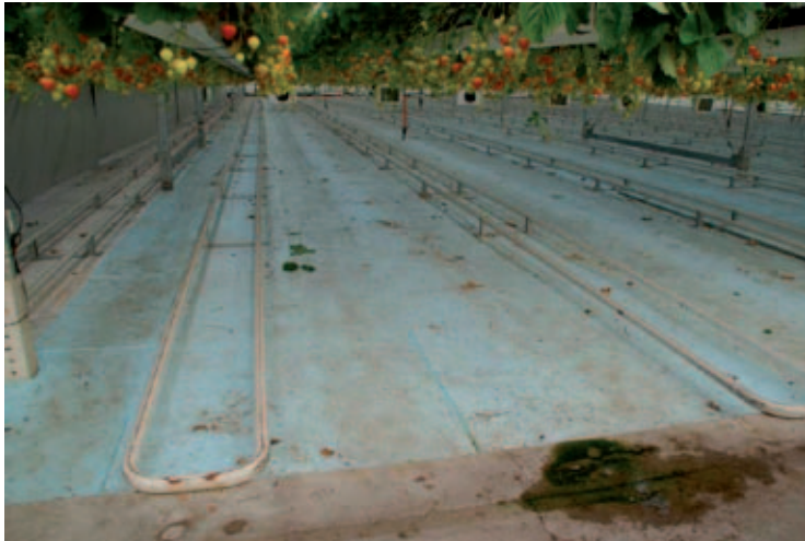
Figuur 39. 4 cm dikke isolatieplaten van geëxtrudeerd polystyreenschuim, naadloos neergelegd en beloopbaar
