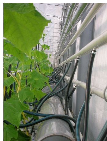
Figuur 2: Links - De luchtbehandelingkast buiten de kas om lucht aan te zuigen voor gecontroleerde ventilatie. In de luchtbehandelingkast zit een ventilator en een warmtewisselaar. Rechts – De hoofdverdeelleiding achter in de kas.
