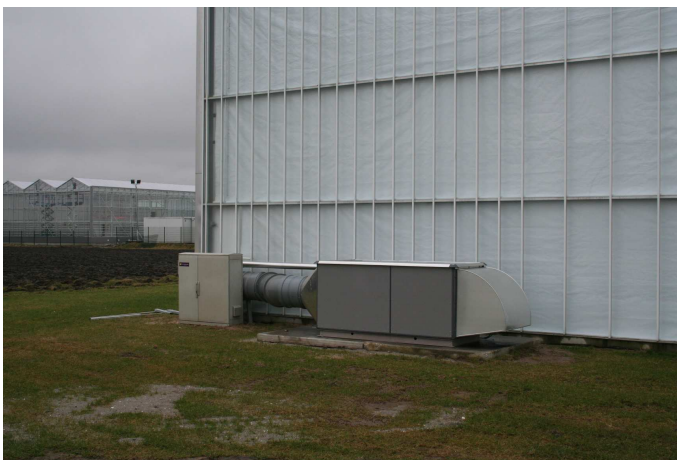
Figuur 2: Links - De luchtbehandelingkast buiten de kas om lucht aan te zuigen voor gecontroleerde ventilatie. In de luchtbehandelingkast zit een ventilator en een warmtewisselaar. Rechts – De hoofdverdeelleiding achter in de kas.
