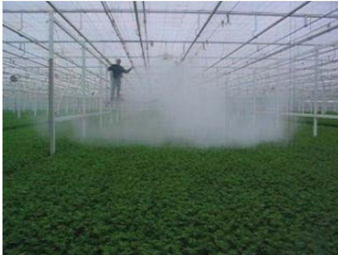
Figuur 8.12. Bij een schoepstand verandering van 3 graden is de werkingbreedte van de ventilator ongeveer 7m.
