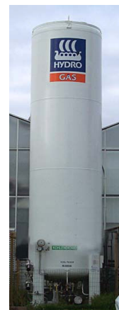
Figuur 4 Vloeibare CO 2 opslag
