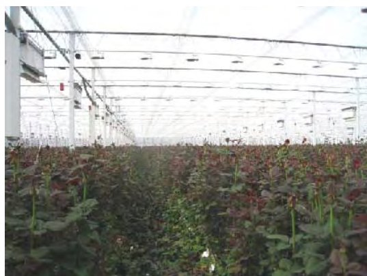
Foto 3 Opstelling koelunits Boonekamp Roses
