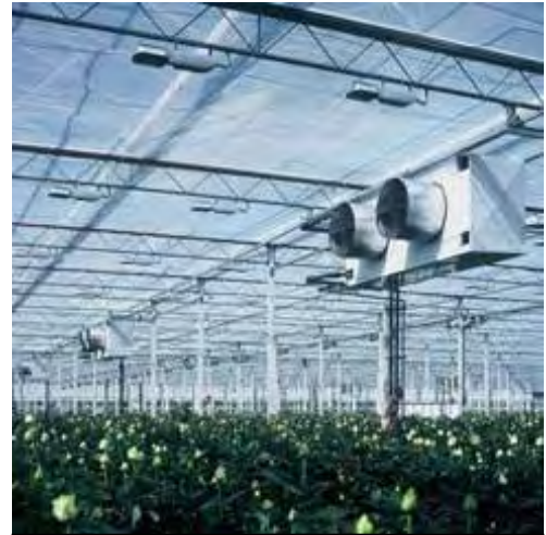
Foto 1 Opstelling koelunits van der Berg Roses
