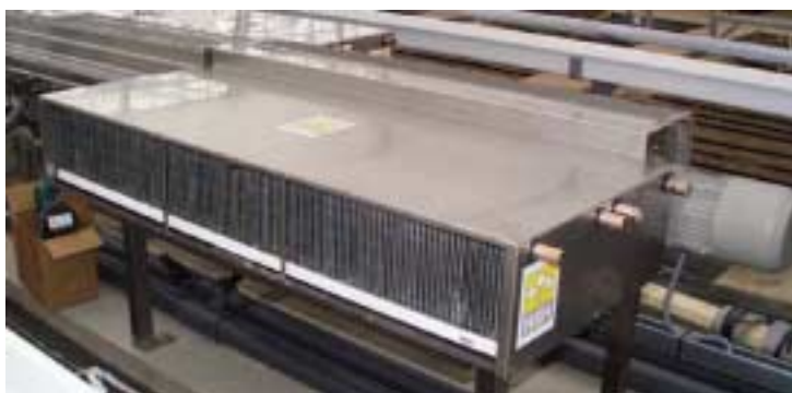
Figuur 4.1. Foto van de FiWiHEx warmtewisselaar die in de Energieproducerende kas is gebruikt.
