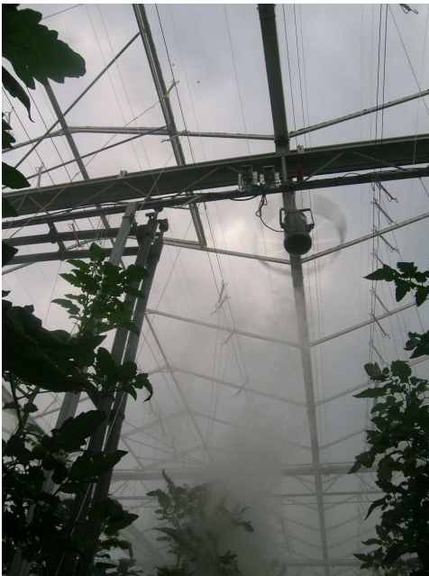
Figuur 16: De Aircobreeze zuigt van onderen lucht aan en verspreid die boven het gewas.
