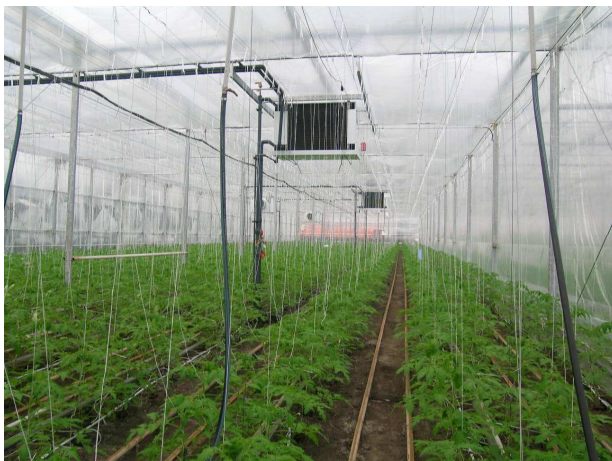
Figuur 3: overzicht proefkas met luchtbehandelingskasten.
