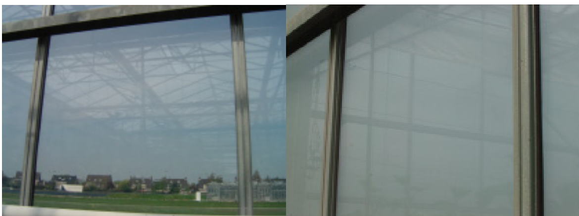
Figuur 5. Helder en diffuus kasdek materiaal op onderzoekskassen.
