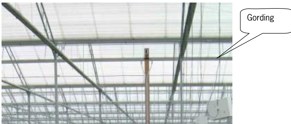
Figuur 3.1. Constructie van het Zigzag-kasdek waarbij forse gordingen noodzakelijk zijn voor de onderlinge koppeling van de ZigZag-platen.
