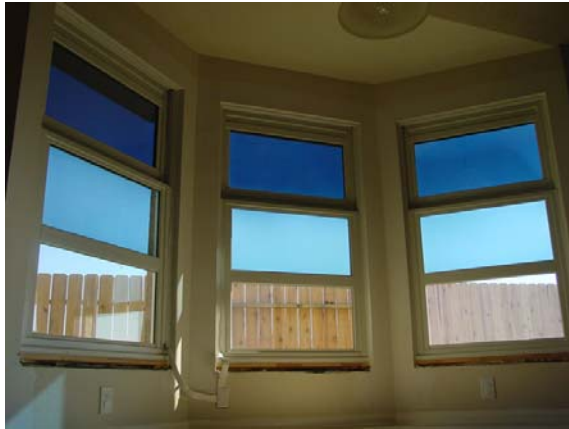
Figuur 8 Electrochrom systeem met instelbare lichtdoorlaatbaarheid
