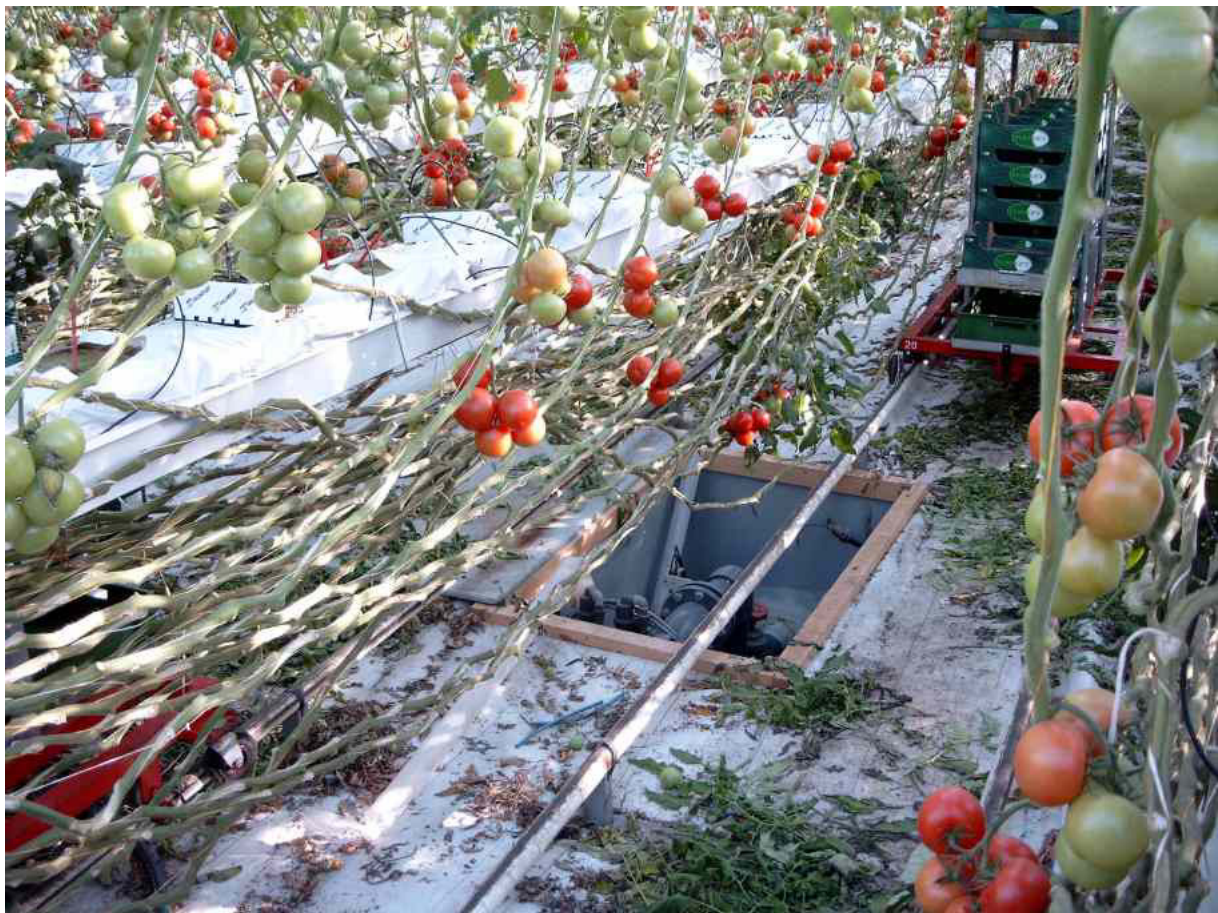
Figuur 3.3 Putbehuizing van één van de bronnen in de kas. In de behuizing bevindt zich de bronkop en meet- en regelvoorzieningen.
