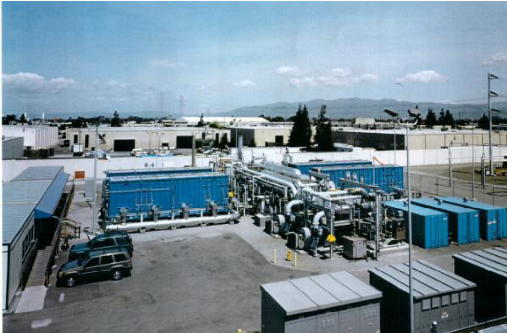
Figuur 9 Foto van de 1,8 MW MCFC installatie in Santa Clara (VS).
