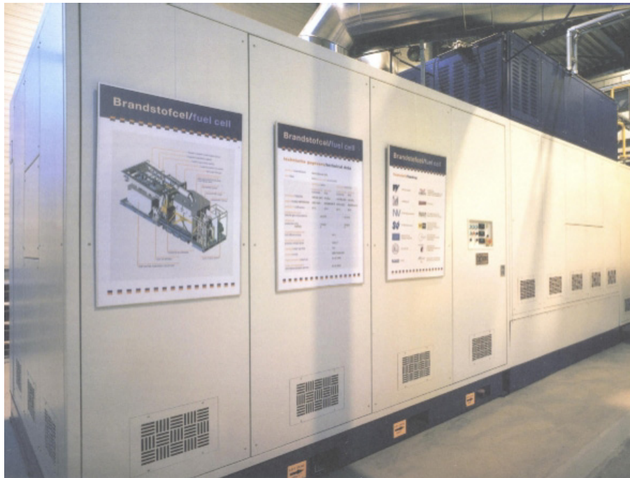
Figuur 12 Foto van de 100 kW SOFC-unit die van 1998-2000 in bedrijf was in Westervoort (NL)
