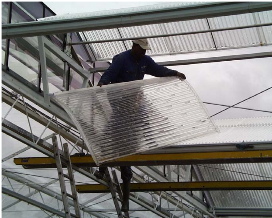
Figuur 2-12 Montage van het zigzag kunststofplaten
