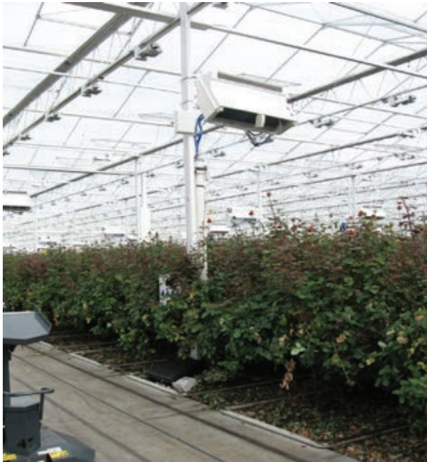
Figuur 2.10. De OPAC 106 in een moderne rozenkas. De warmtewisselaar wordt zowel voor koelen als voor verwarmen gebruikt. In de verwarmingsmodus gedraagt het systeem als Laag-temperatuur verwarmingssysteem.
