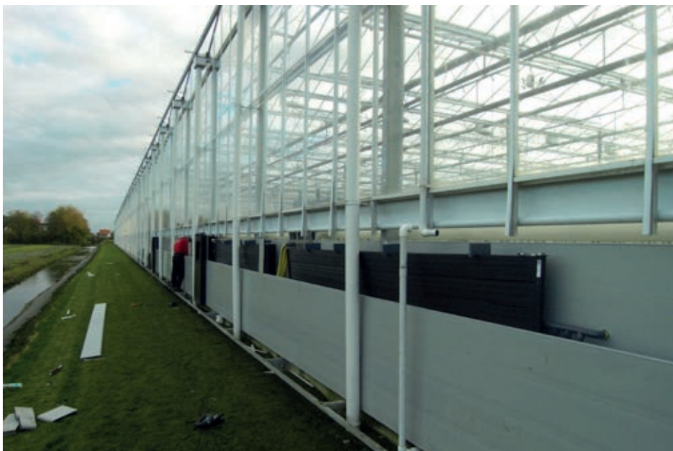
Figuur 8. Installatie van de luchtbehandelingskast (ALS) door Formflex.
