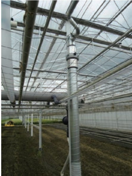
Figuur 2.1. Ventilator voor kasluchtcirculatie. Figuur 2.2. Luchtbehandelingskast.
