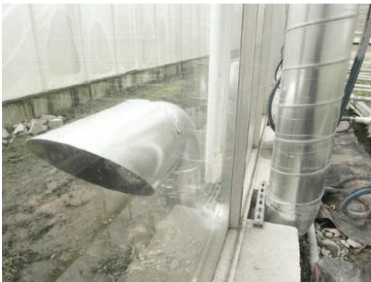
Figuur 2.3. Aanvoer van buitenlucht door de voet.
