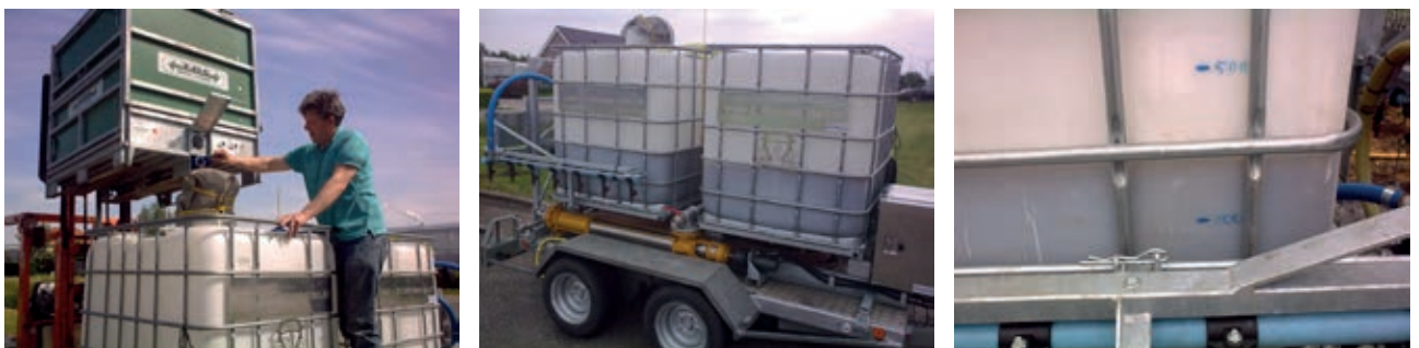
Figuur 66: Primer overbrengen in doseerwagen.
