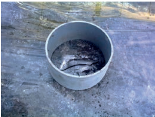
Figuur 12: Maken van een opening in de folie
