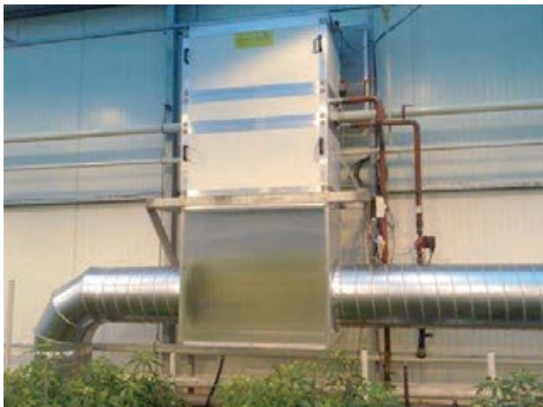
Figuur 5: LBK aan de achtergevel van het proefvak.
