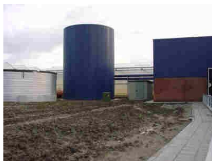
figuur 23 Voorbeeld van een watertank als opslagbuffer.
