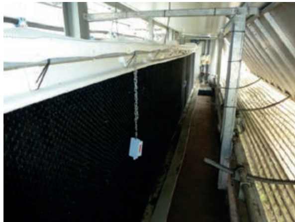
Figuur 6.4. Het vocht- en warmtewisselende oppervlak dat in de schets als rood blok wordt weergegeven is in de praktijk een open structuur waar de hygroscopische vloeistof langs het oppervlak van de structuur stroomt en de lucht door de open ruimten.
