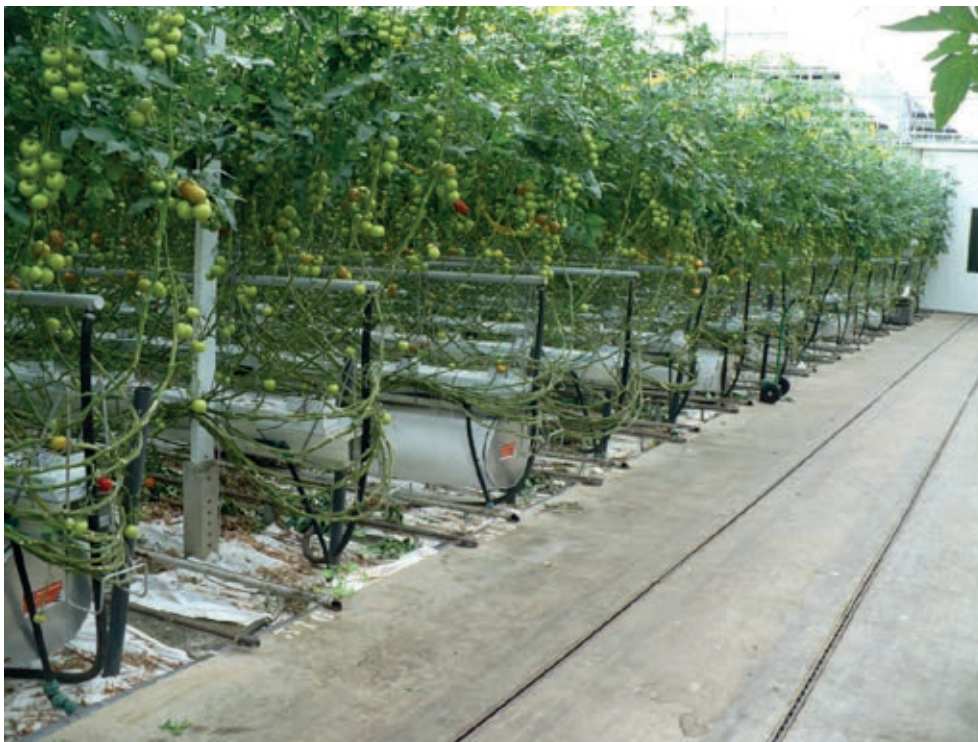
Figuur 3.3. Er zijn twee slurven per 8 meter tralie onder de hangende goot geplaatst. Omdat er 5 goten per tralie hangen is de verdeling niet helemaal evenredig.
