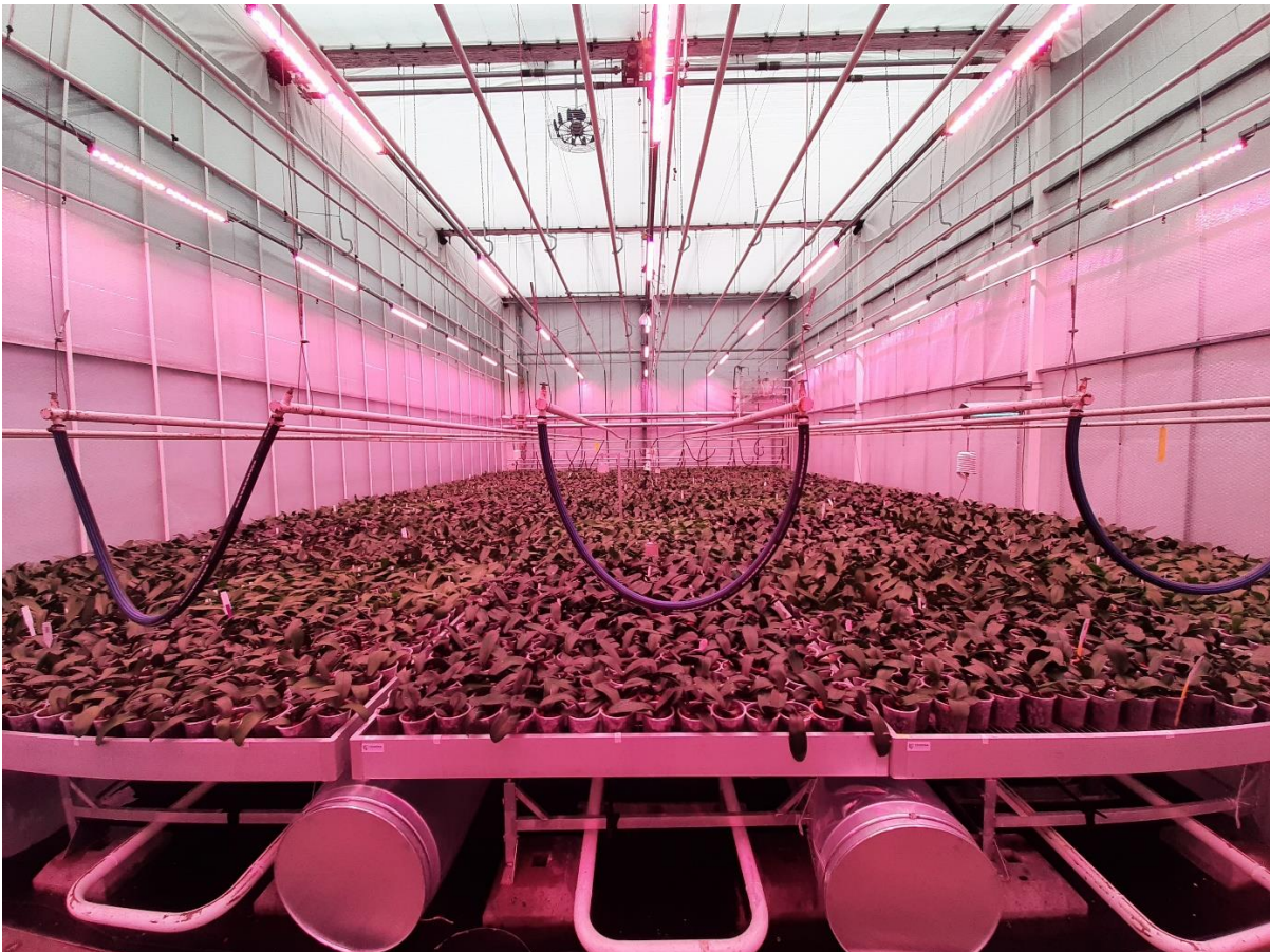
Foto 2 Overzichtsfoto van de afdeling waarin de slurven onder de tafels zichtbaar zijn en de groeibuis geplaatst 70 cm boven de potten.
