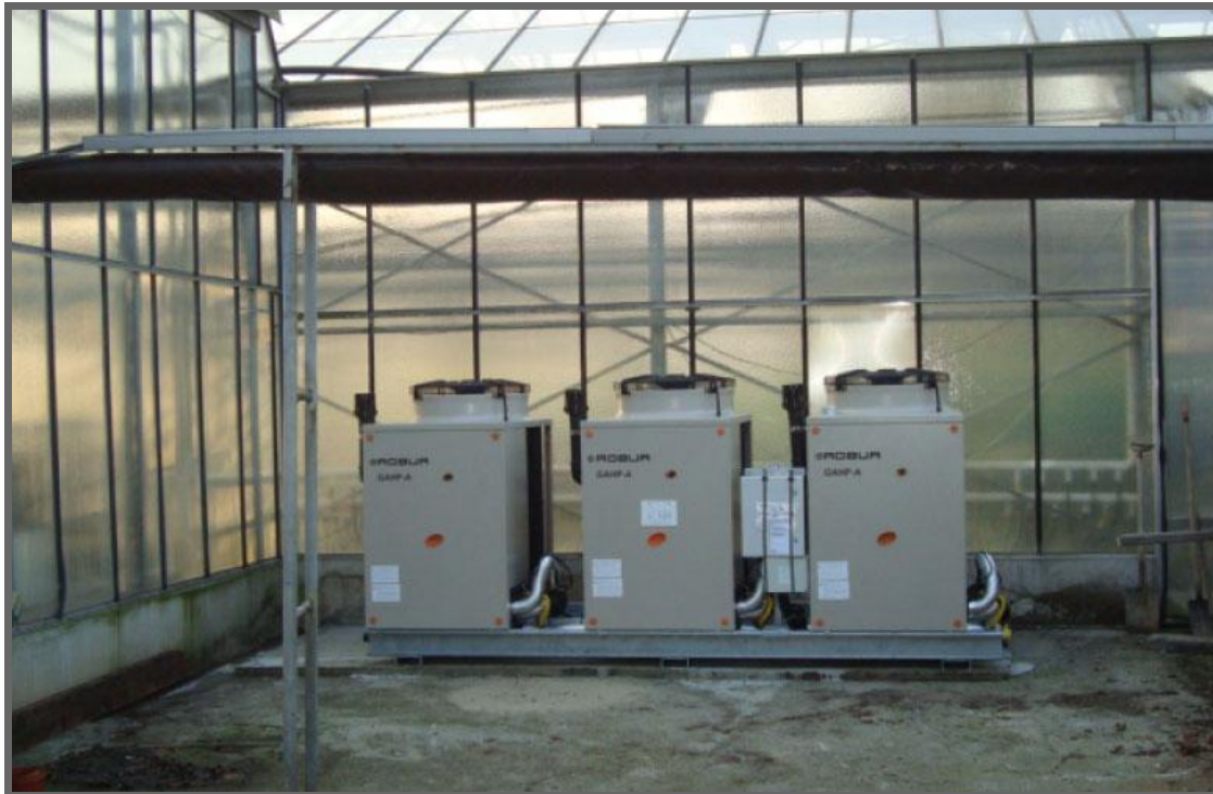
Figuur 9 Drie Robur gasabsorptiewarmtepompen bij bloemkwekerij Lokeren in België (bron: CoolingWays)
