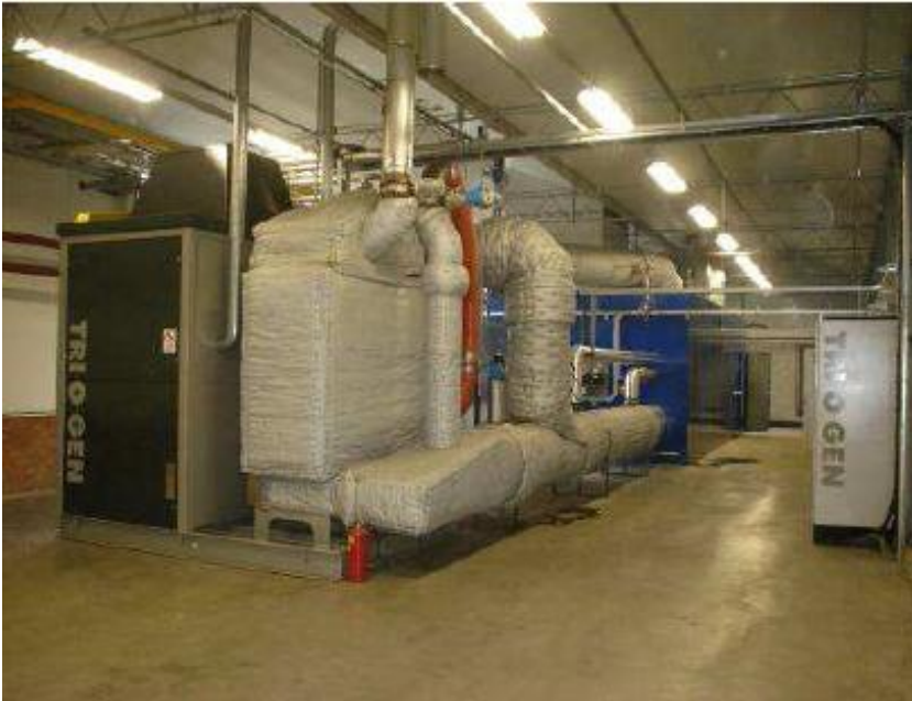
Figuur 10 Tri-O-Gen ORC bij Olij Rozen in De Kwakel
