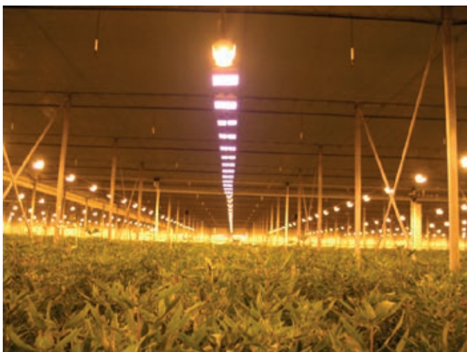
Figuur 2 Het LED vak omringd door SON-T lampen.
