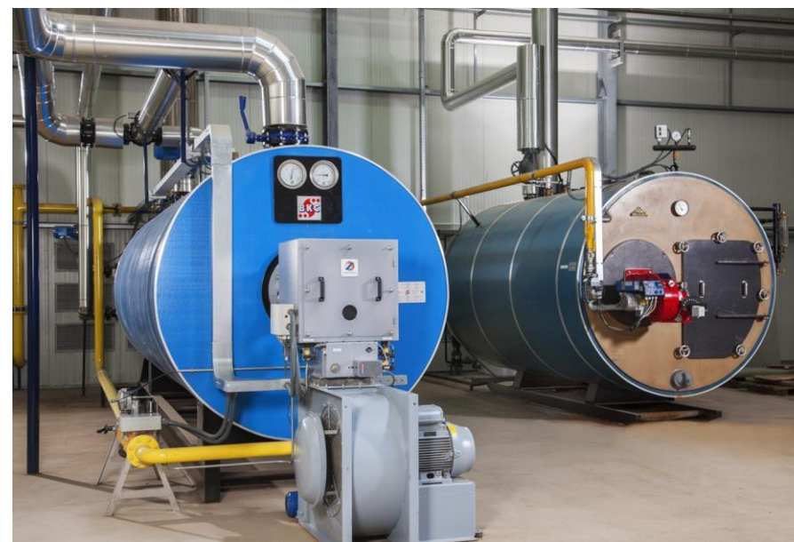
CV-ketels glastuinbouw (foto Zantingh)
