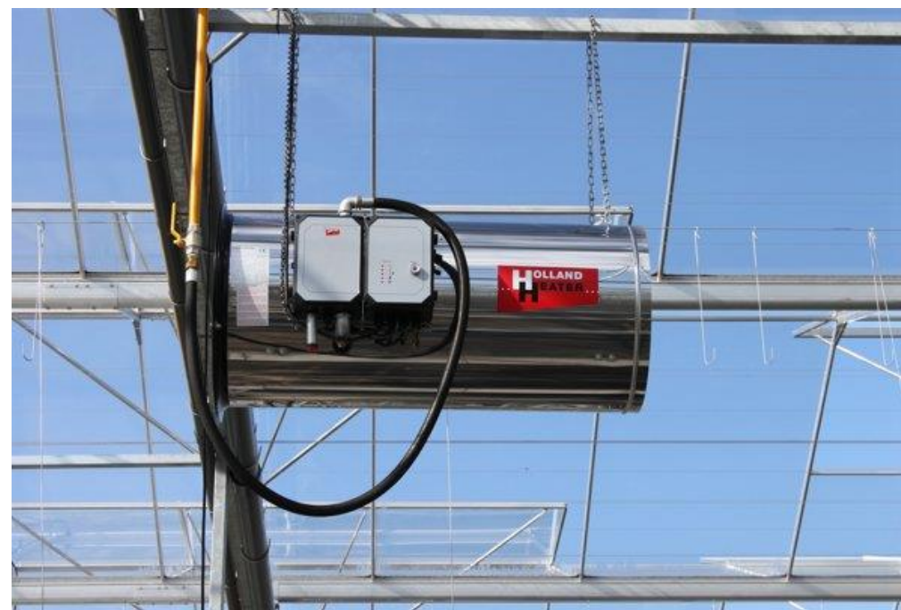
Gasgestookte luchtverwarmer. Foto: Holland Heater
